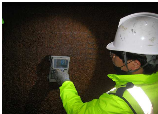
철근탐사 시험(피복두께 확인)
